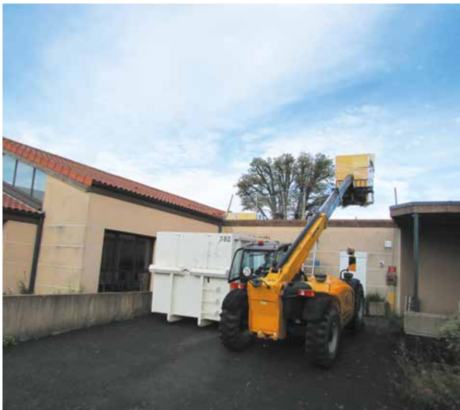
Travaux toiture du CRA.
