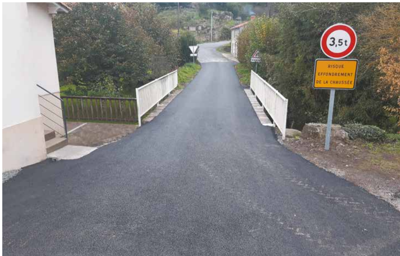
Pont après travaux.
